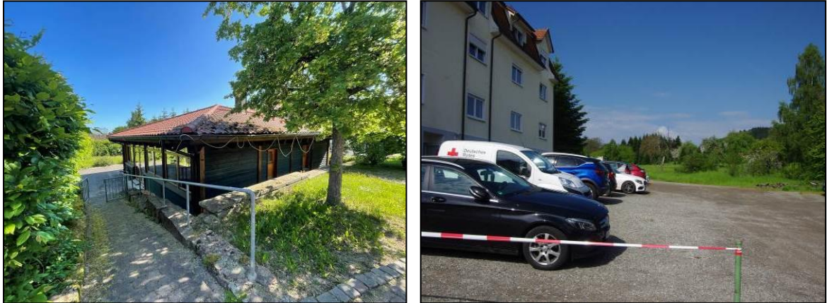
Abb.: Café-Gebäude (l.) und Parkplatz im Norden (r.)
