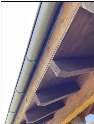
Abb.: dicht verschlossener Dachüberstand am Café
